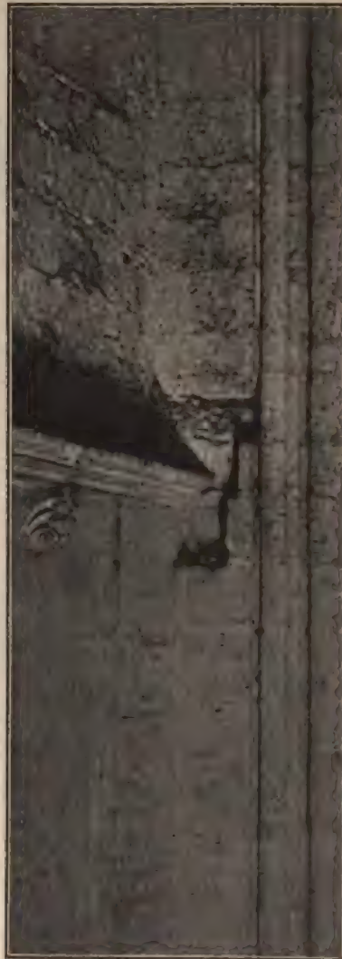
COLONNE D'ANGLE DU CLOCHER NORD
